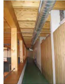
Seit Inbetriebnahme der Solaranlage im August 2005 musste die Sporthalle **noch kein einziges Mal „nachbeheizt“ werden, wobei die Hallentemperatur immer über 18°C gehalten werden konnte!** Zudem findet die solar erwärmte Luft zusätzliche Verwendung zur Querlüftung der Duschräume. Fazit ist letztendlich eine erfreuliche Reduzierung der Betriebskosten für die Kommune – mit Nutzung von Sonnenenergie
