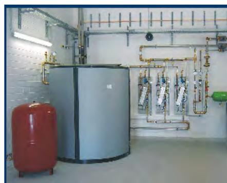
SYSTEM 018: 3 FWE-Module ( mit geöffneten Dämmhauben) und 1 Pufferspeicher mit integrierten Wärmetauschern
